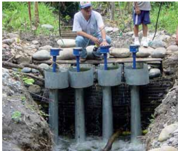
Installation der Turbinen (Quelle: IT Power, UK)
