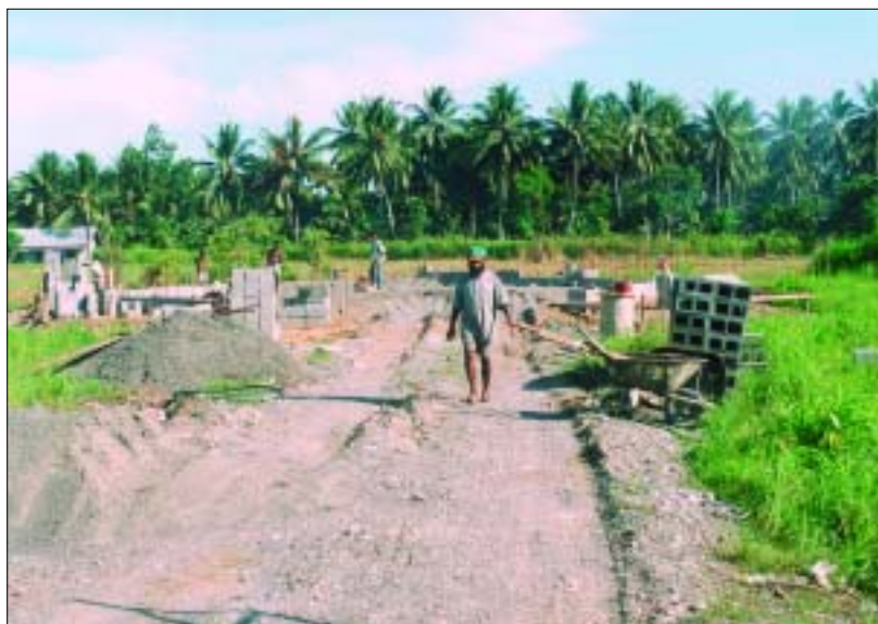
Mit dem Bau wurde sofort begonnen
